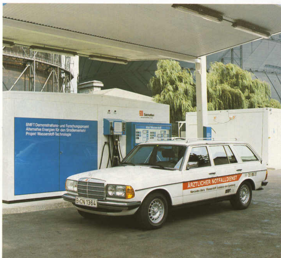
Wasserstofftankstelle in Berlin
